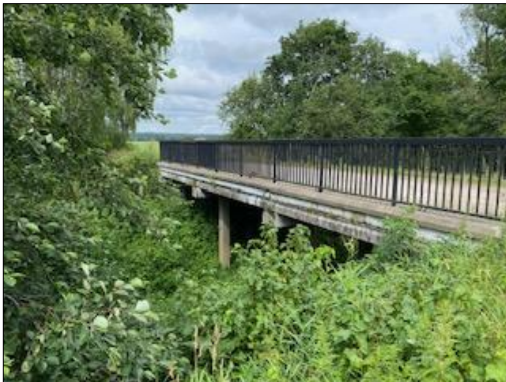
11 pav. Melioracijos tiltas Šilutės r. sav., 2025 m.
