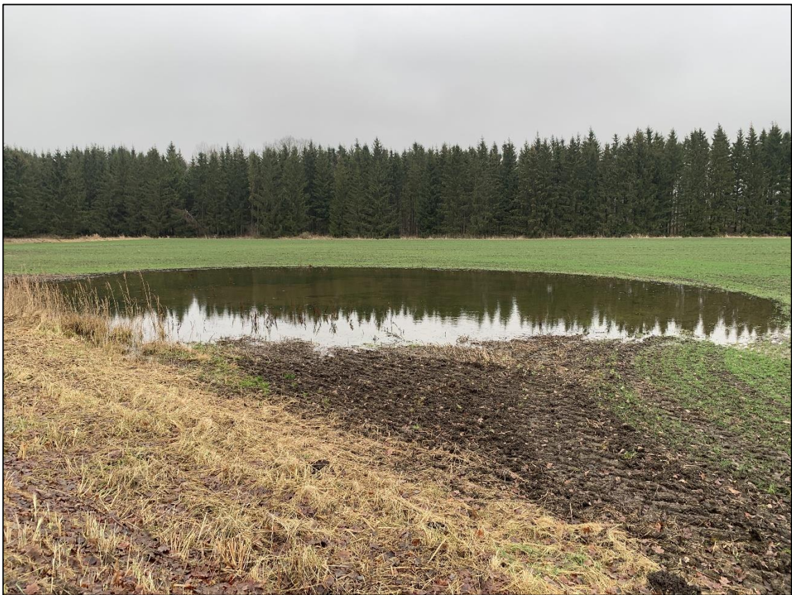
17 pav. Galimai dėl mažo ploto ortofotografinių vaizdų segmentavimo būdu nenustatytas užmirkusios melioruotos žemės plotas. Įtrauktas į blogos būklės melioruotos žemės sluoksnį.
