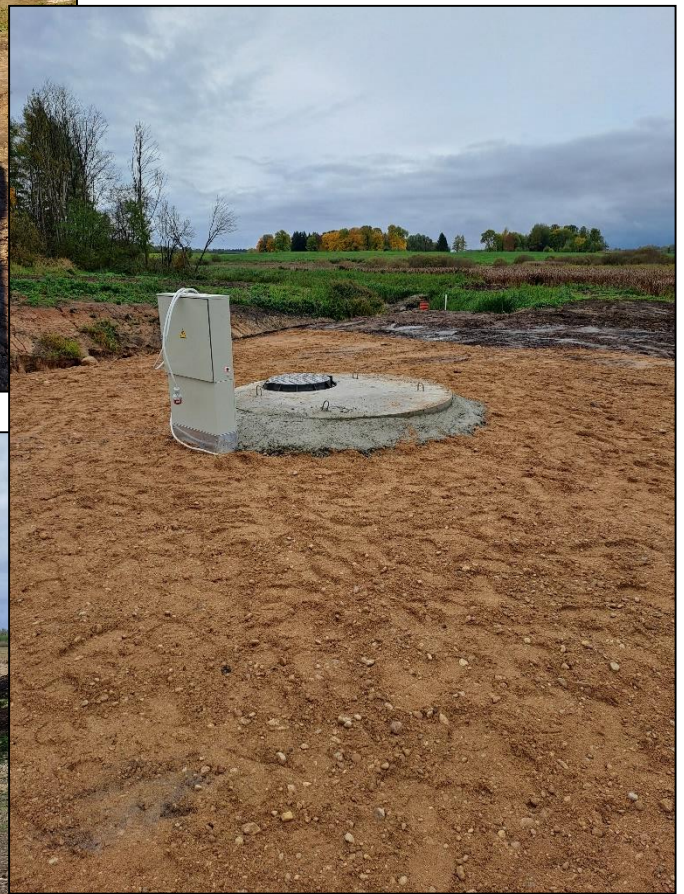
4 nuotr. Rekonstruota Laičių polderio melioracijos siurblinė.
