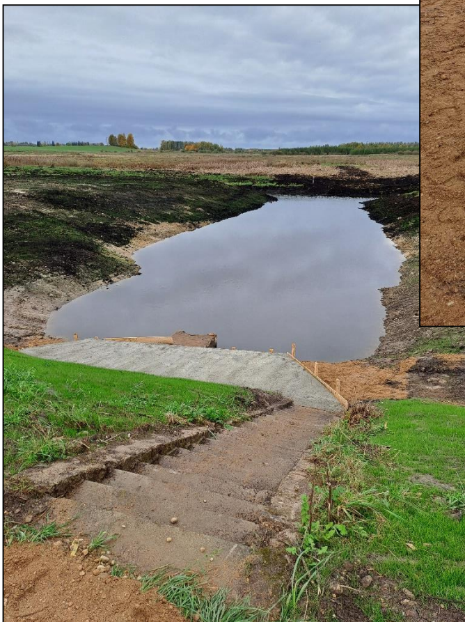
5 nuotr. Laičių polderio rekonstrukcijos darbai.
