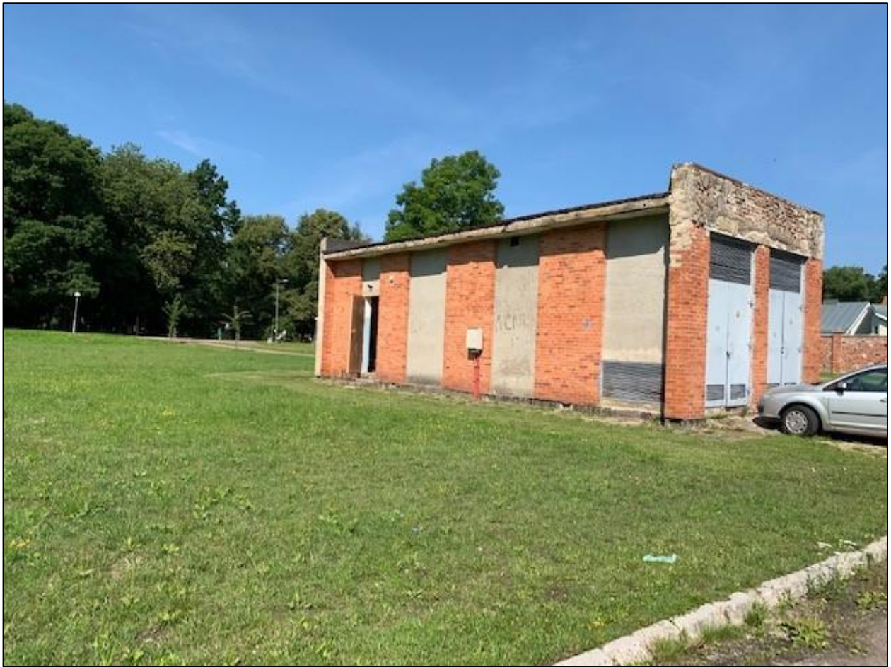
Traksėdžių 2 melioracijos siurblinė
