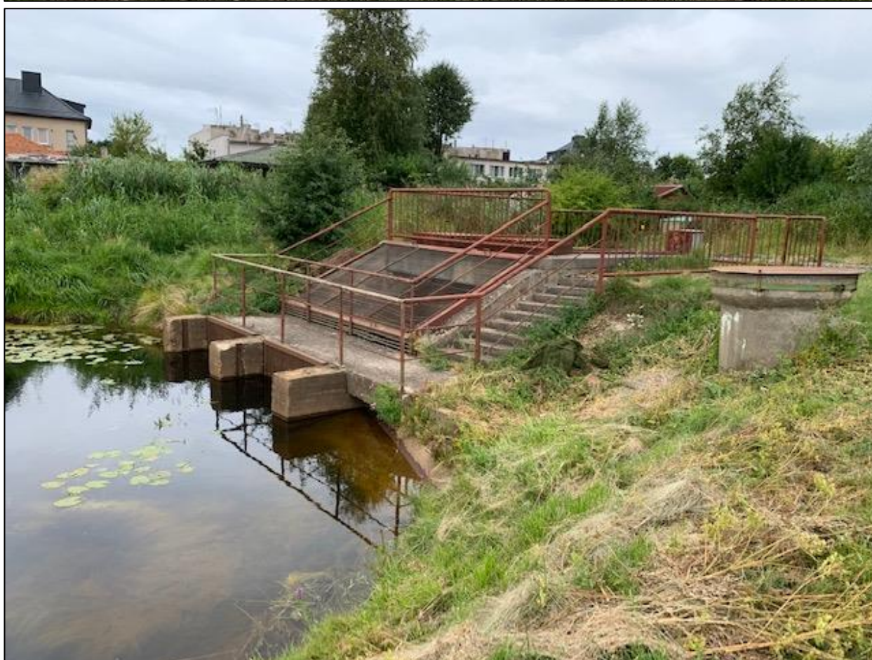
Šventosios polderio melioracijos siurblinė
